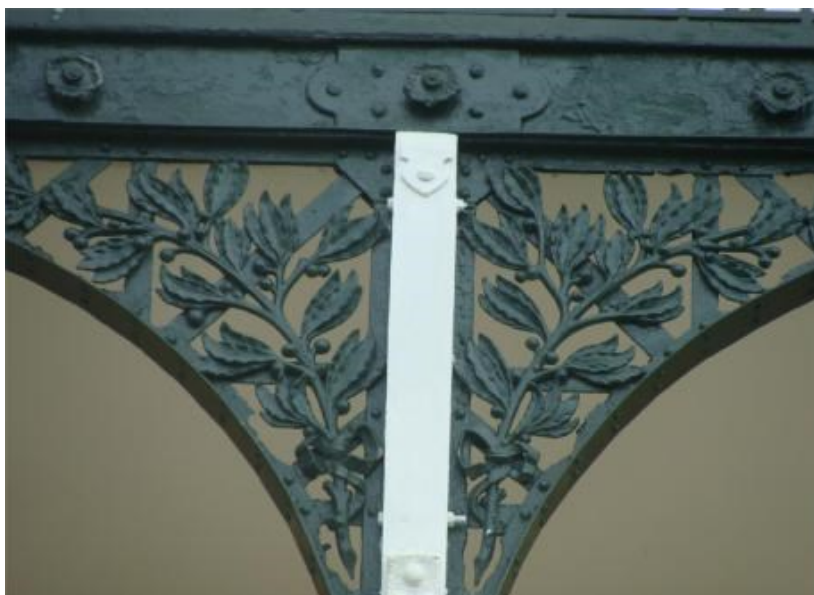
Figura 4 - Detalhe das iniciais do nome de Antônio Lemos (AL) nas grades do prédio do Conjunto Arquitetônico. Fotografia da autora.
